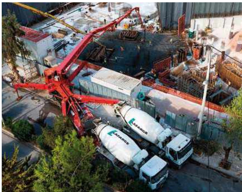
Σκυροδέτηση των κεντρικών γραφείων της Anangel Maritime
