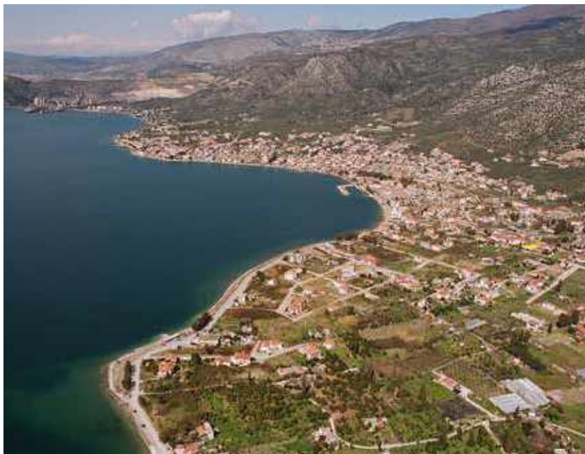
Άποψη του εργοστασίου τσιμέντου στο Βόλο και της βιομηχανίας αναψυκτικών ΕΣΑ. Τα υδάτινα απόβλητα της ΕΣΑ μεταφέρονται στο εργοστάσιο τσιμέντου μέσω ενός υπόγειου αγωγού
